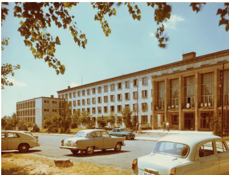
A Komárom Megyei Tanács épülete, 1967.
